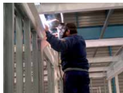
Trabajos de soldadura.
